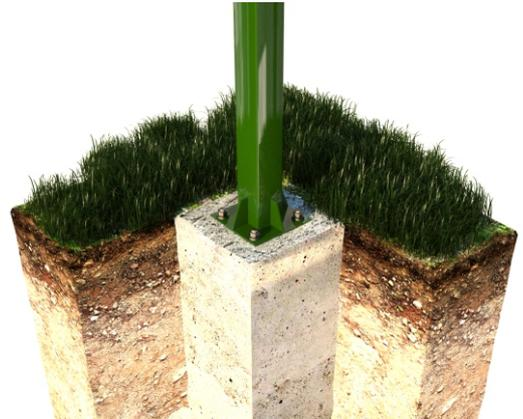
2. Установка стоек с фланцем на заранее подготовленный фундамент (крепление анкерами)
