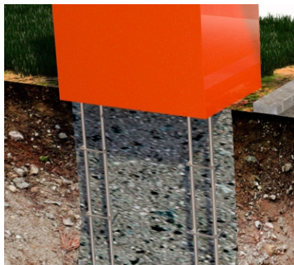
2. Монтаж на заранее установленные армокаркасы.
